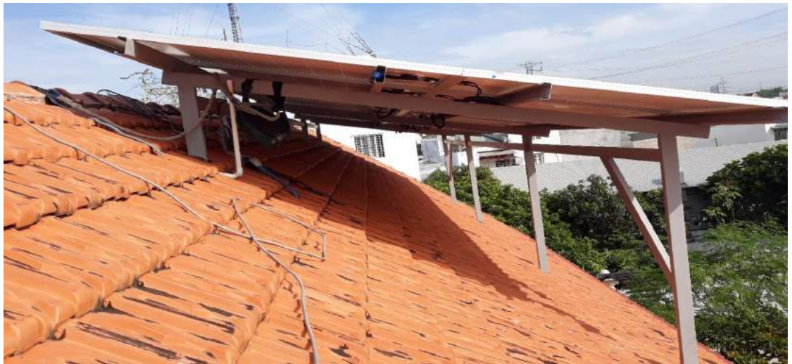
Hình 2.14: Lắp đặt tấm pin bằng giàn khung sắt trên mái ngói
