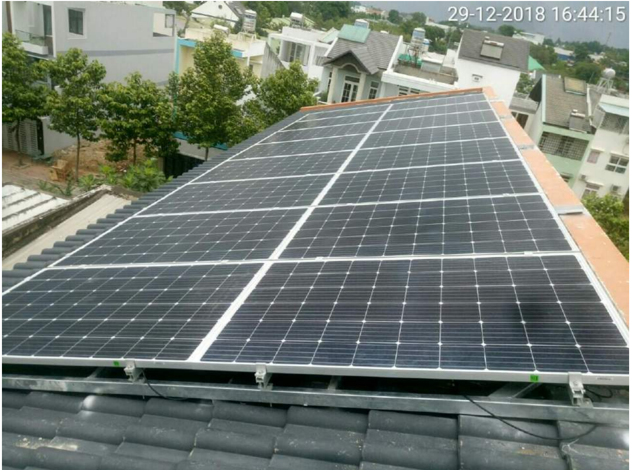
Hệ áp lên mái ngói cổ - Nhà Anh Khoa Bình Dương
