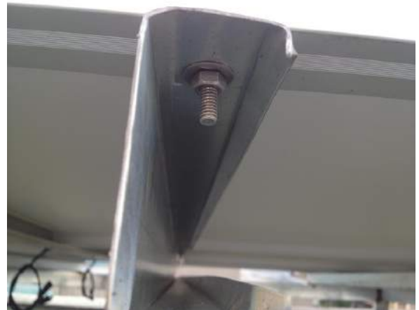
Hình 2.4: Cách bắt ốc cố định tấm pin vào giàn đỡ
