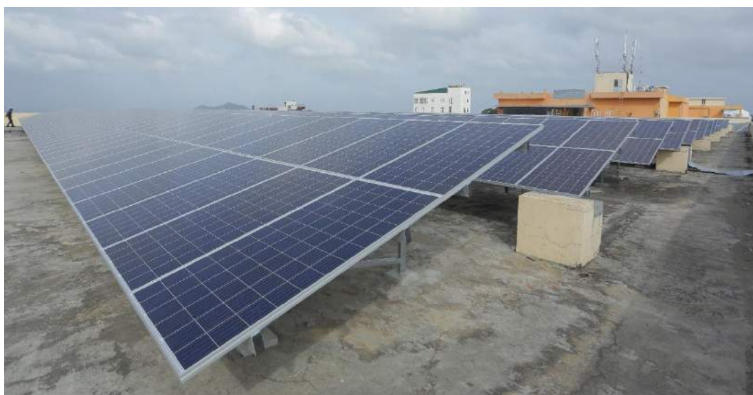
Hình 2.6: Cách lắp đặt trên thềm bê tông
