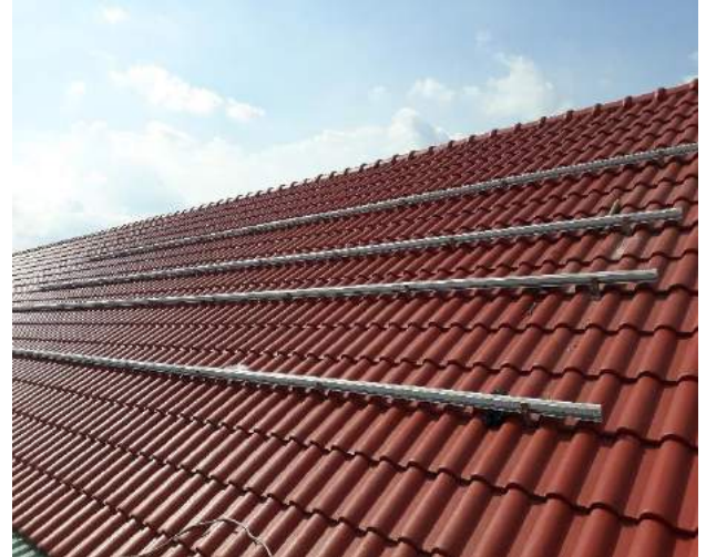
Hình 2.12 : Lắp đặt rail nhôm lên bass hook
