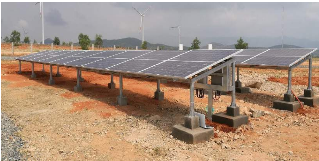
Hình 2.5: Cách lắp đặt trên mặt đất
